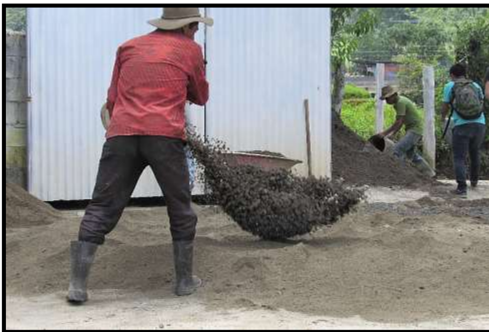
Photographie 19. Préparation du ciment pour la construction du centre de la coopérative Tejidos Cotzal Juillet 2017
