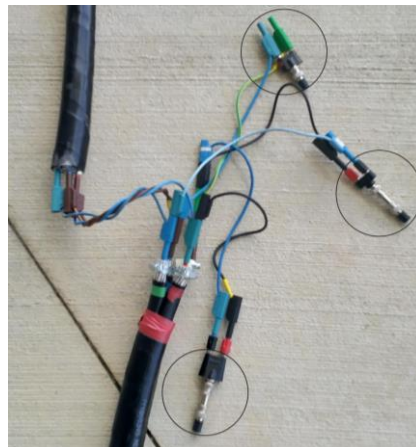
Figure 2-7 : Trois résistances de 50 Ohm connectées en étoile aux extrémités d'un câble électrique
