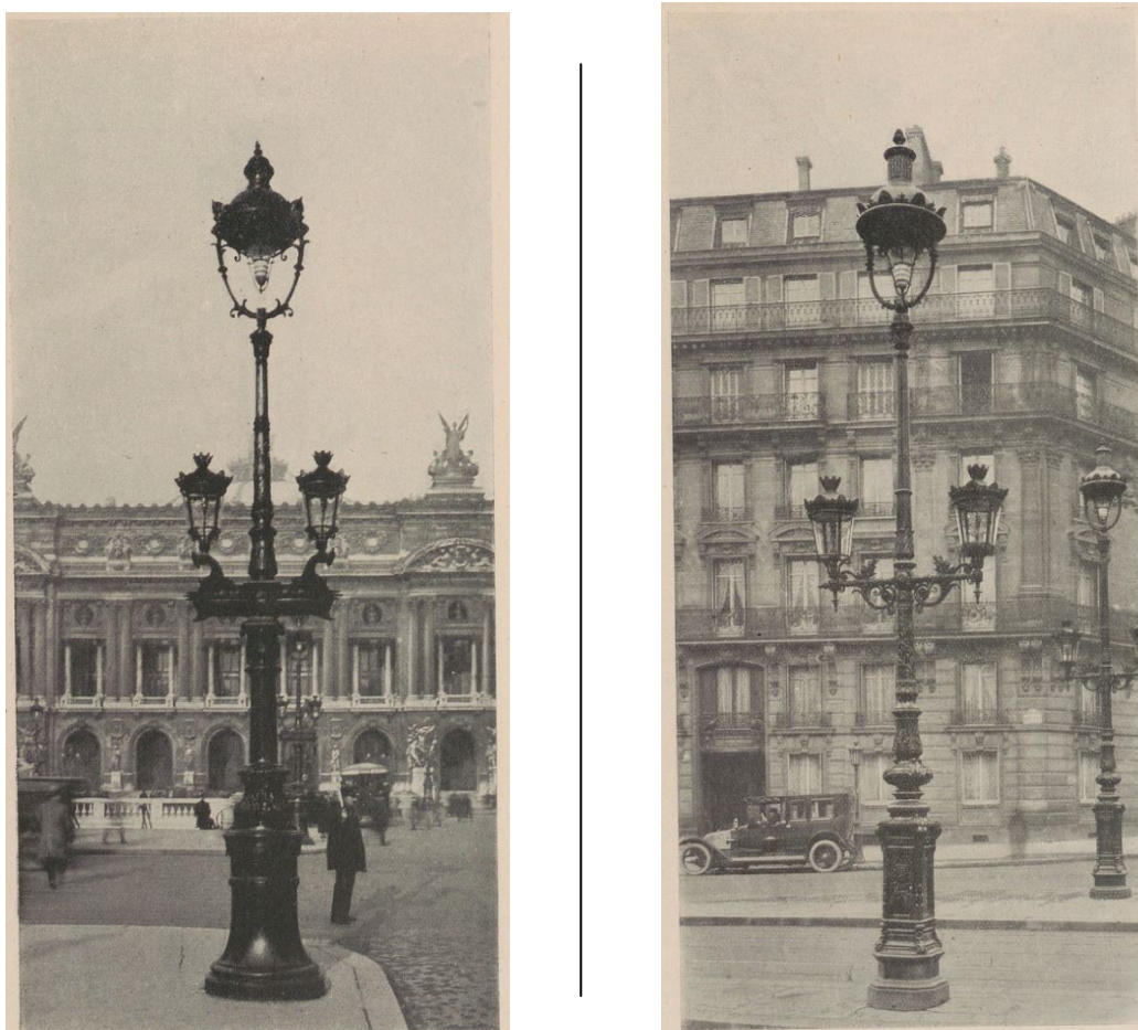
Figure 55 - Photographies d'un candélabre électrique de la Place de l'Opéra (à gauche) et d'un candélabre mixte gaz et électricité (à droite). Extrait de l'ouvrage de R. Boutteville.
