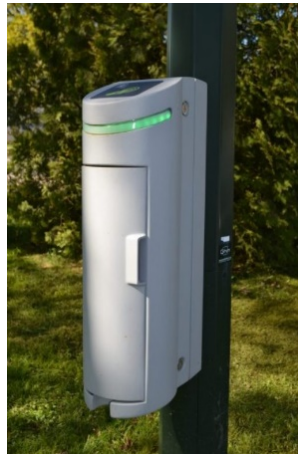
Figure 98 - Borne "City Charge" installée sur un mat de lampadaire. Extrait d'une illustration de l'offre "Alizé" de Bouygues Energie & Services.
