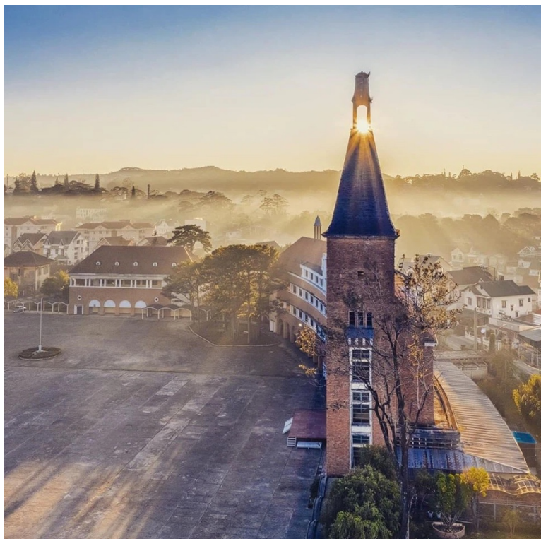
Photo 19 : L'école supérieure de Pédagogie de Dalat avec les bâtiments hérités de l'époque française
