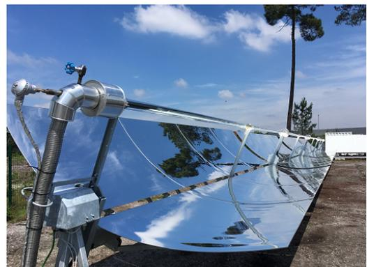
(a) CST de Condat-sur-Vézère (France) : Capteurs plans (4200 m<sup>2</sup>) avec tracking solaire. (b) Ligne de capteurs cylindro-paraboliques
