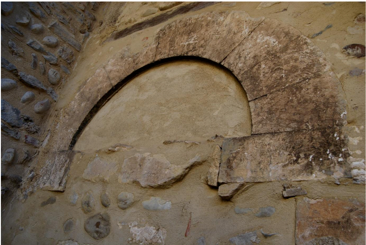
Tympan de la porte bouchée sur la façade principale du prieuré
