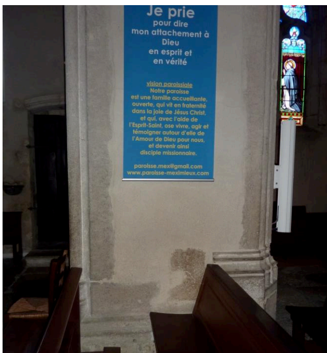
Figure 59 : Meximieux : épaisseur de la pile sud.
