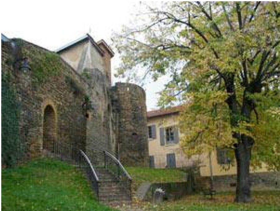
Figure 4 : Couzon, vestiges du château muraille orientale et tour.
