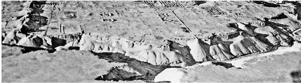
Fig. 93 – Vue aérienne du rempart méridional et courtines (YUAG).
