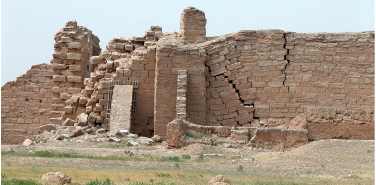
Fig. 74 – Europos-Dura , tour 14 : Le jeu des blocs de gypse
