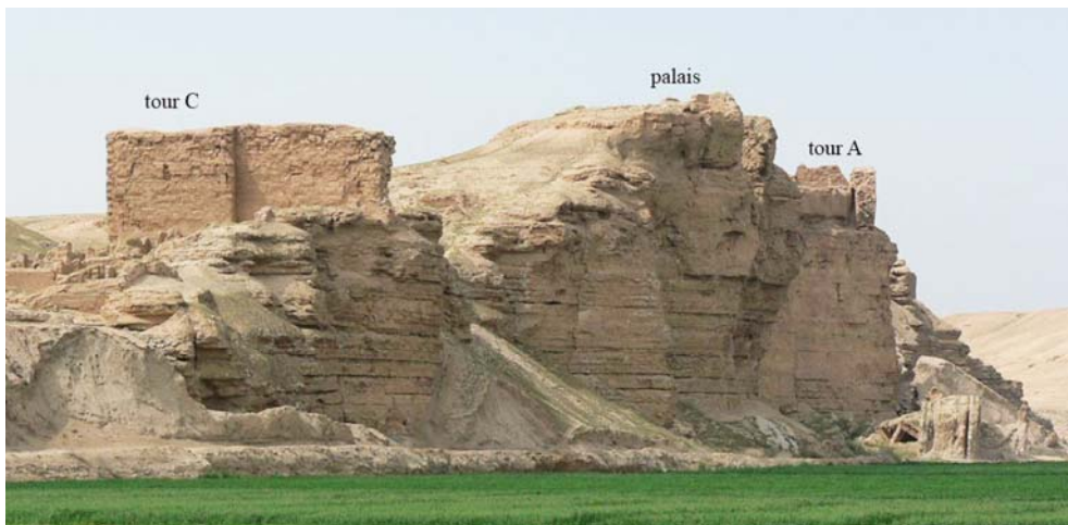
Fig. 19 – Citadelle : falaises et ancrage du mur nord-ouest de la tour A (MFSED).
