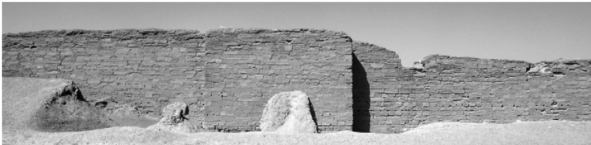
Fig. 69 – Les assises régulières du rempart occidental.
