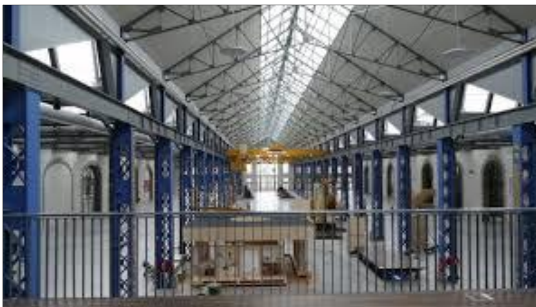
29 La salle des machines. (Source personnelle)
