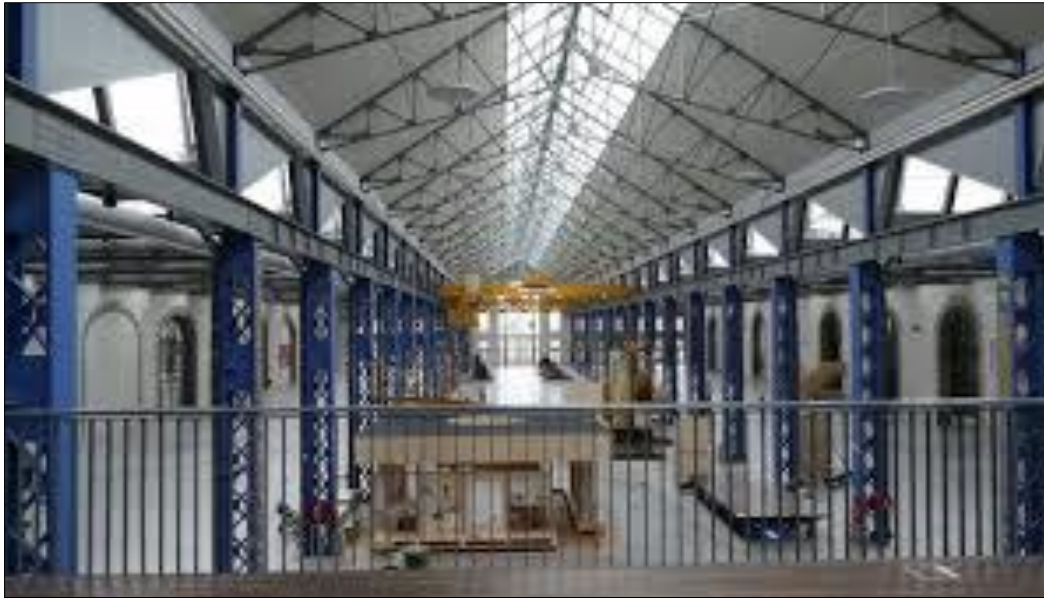
29 La salle des machines. (Source personnelle)
