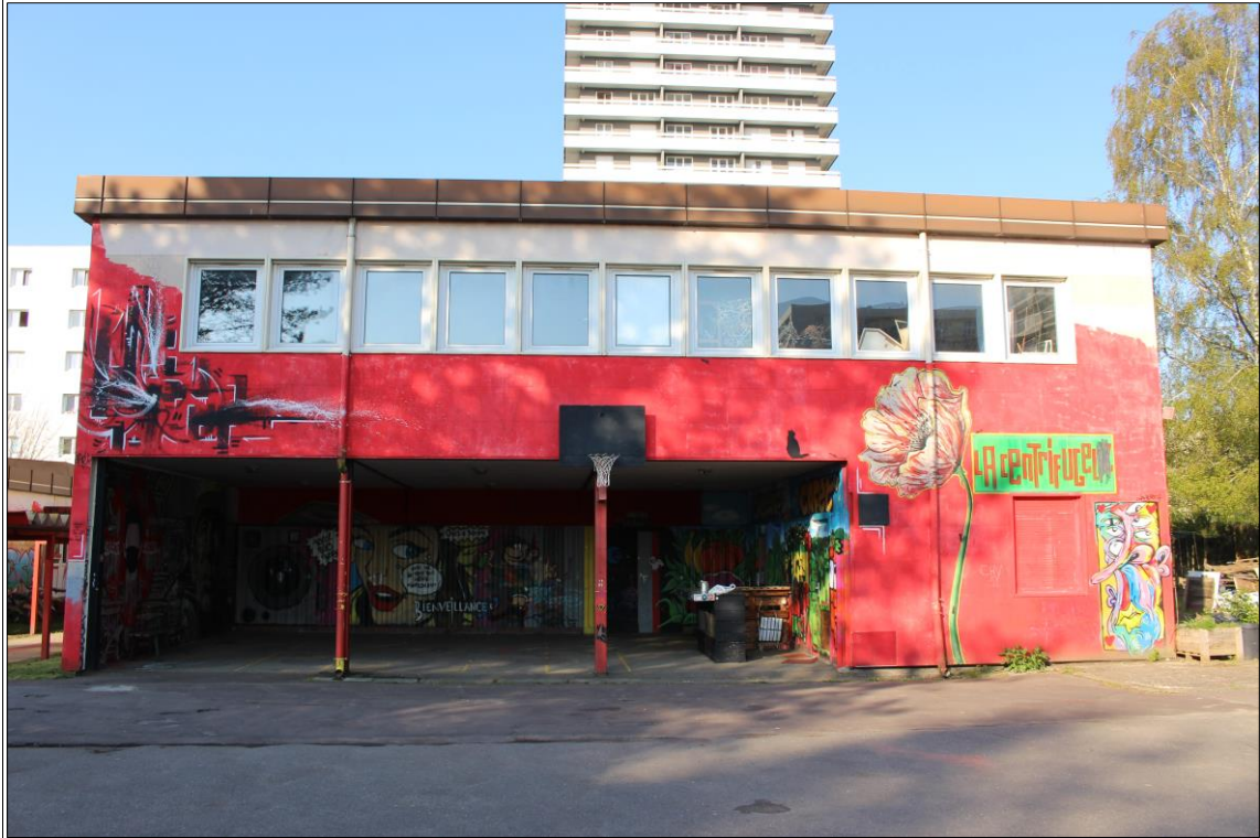
5 Le bâtiment de la Centrifugeuz (530 m 2 rez-de-chaussée et étage). (Source : La Centrifugeuz)
