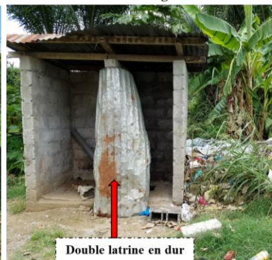
Photo 4 : Identification d'une latrine traditionnelle en dur au quartier Mikolongo
