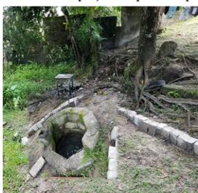
Ce puits construit avec les parpaings. Il est régulièrement sans support de fermeture. Cette eau est utilisée par exemple pour faire la lessive, d'où la table au centre et les vêtements à droite (en haut). L'alignement des parpaings a pour objectif de ne pas laisser passer les eaux résiduelles qui peuvent se déverser dans le puits. Toutefois, la couleur verdâtre montre que les conditions sont favorables au développement des lichens et des mousses.
