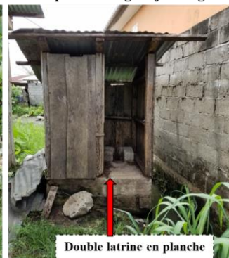
Photo 5 : Identification d'une latrine traditionnelle en planche au quartier Angondjé village
