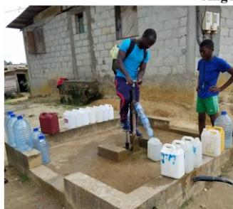
Cette pompe laisse l'eau sortir en appuyant sur la pédale avec le pied. On constate que naturellement le remplissage des bidons que voici est difficile à cause de la faible fluidité, en plus de l'effort physique qu'exige ce modèle de pompe. Alors, l'encombrement et les files d'attente des populations sont inévitables. L'association de 2 bouteilles Andza permet d'avoir un entonnoir artisanal qui essaye de réduire la durée d'attente.
