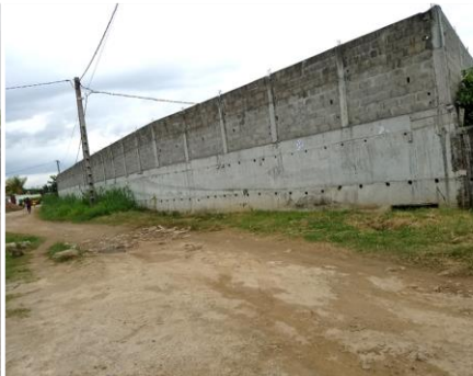
Photo 23 : Route carrossable dégradée (Zone Okala carrière)
