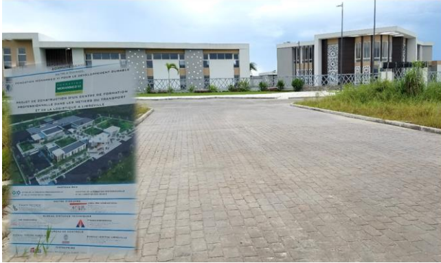
Photo 1 : Centre de formation professionnelle des métiers du transport et de la logistique au quartier Marseille II
