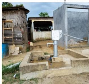
Aperçu de la pompe publique installée chez le chef du quartier. Elle a une seule sortie d'eau et le mécanisme de cette pompe n'est pas très différent de ce qui est présenté dans la figure C. À la différence que cette pompe laisse sortir l'eau par l'action manuelle de la main. La fluidité du liquide est également faible, donc l'entassement des personnes se fait constater. L'activité est plus pénible pour les femmes et les enfants.
