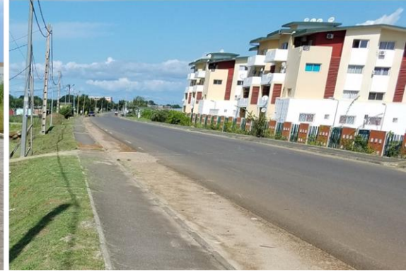
Photo 2 : Identification des logements de la résidence « Les Bougainvilliers » au quartier Avorbam
