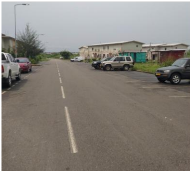
Photo 22: Route bitumée (Zone des logements sociaux d'Angondjé)
