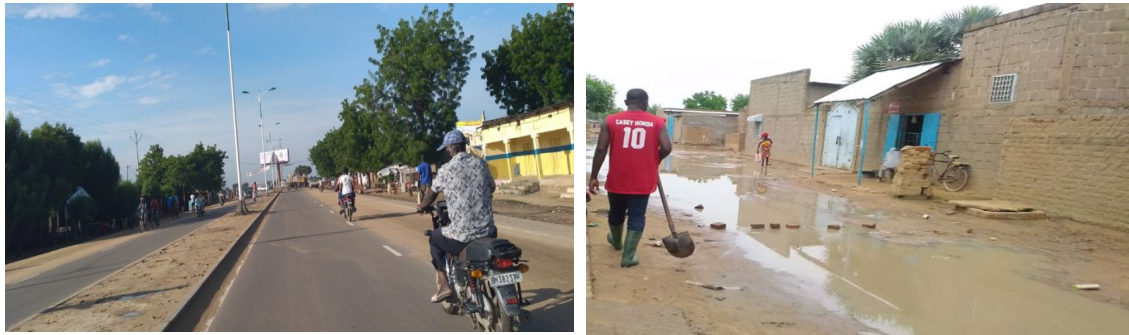
Figure 15 : Routes à deux voies dans le centre-ville (gauche) et une voie bourbeuse pendant la saison de pluies (droite)
