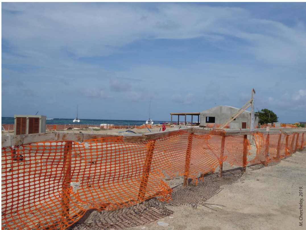
Photographie 35. Les travaux de reconstruction des carbets à la Baie Orientale en août 2019.
