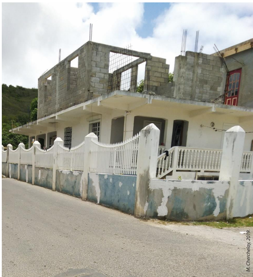
Photographie 29. Ajout d'un étage sur une maison du quartier d'Agrément sans modification de la structure d'origine, août 2019.
