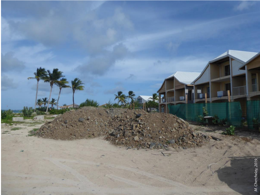
Photographie 28. Des résidences réparées le long du littoral en juillet 2019, à la Baie Orientale, à 3km de Quartier d'Orléans.
