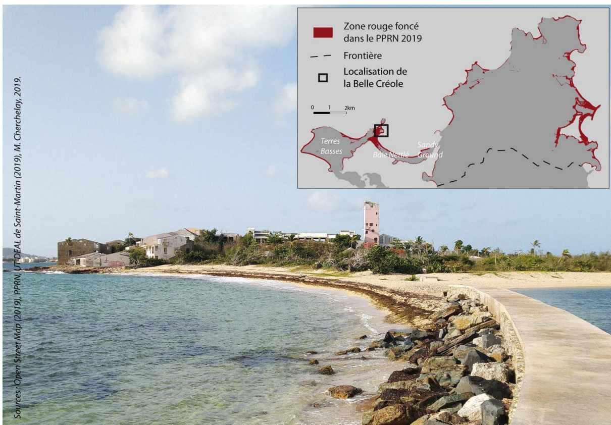
Photographie 51. Le complexe hôtelier abandonné de la Belle Créole, en partie situé en zone inconstructible.
