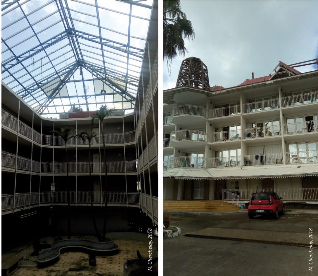
Photographie 37. L'impact d'Irma sur l'intérieur et l'extérieur du Beach Hotel, Marigot.
