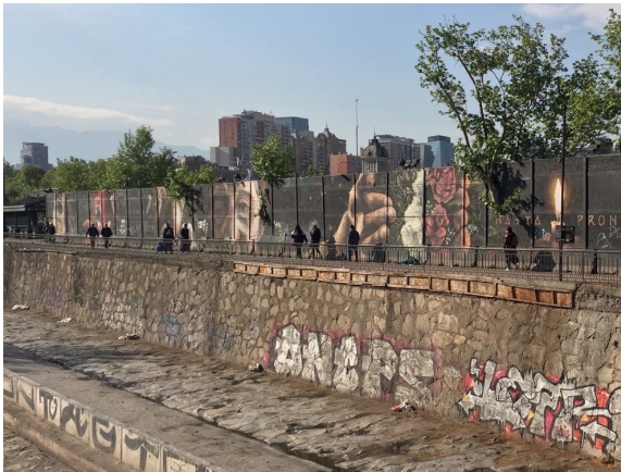
Jeudi 03.10.19 – 9h00-11h00. Vue vers le sud-est Peintures murales et tags le long des clôtures du chantier du métro et de la berge inférieure sud du fleuve Mapocho
