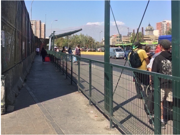
Mardi 24.09.19 – 15h00-17h00. Vue vers la Cordillère L'accès aux arrêts de bus situés au bord sud de la zone de chantier de Métro
