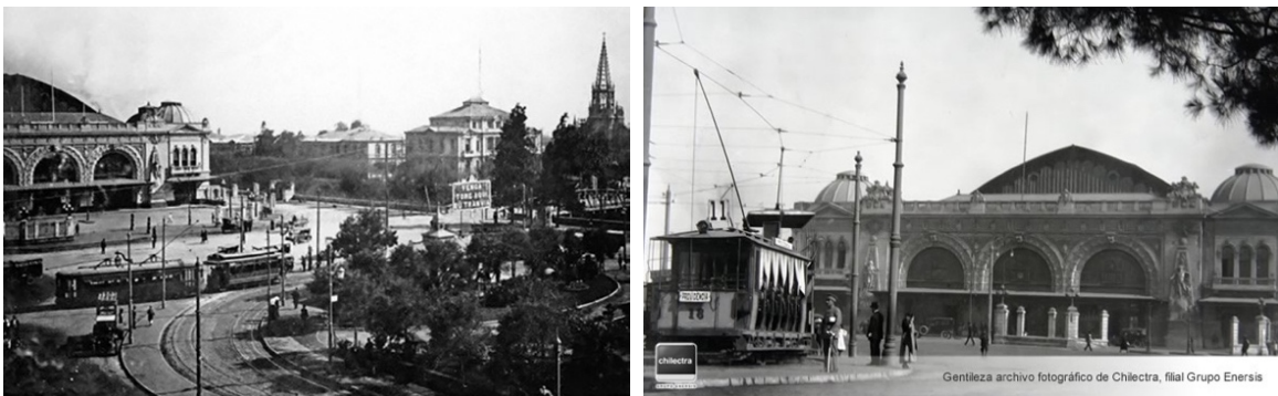
Figure 34. La Estación Mapocho et le terminal de tramway au début du XXème siècle
