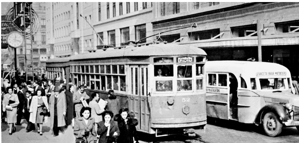
Figure 42. Tramway et bus dans le centre de Santiago, date indéfinie
