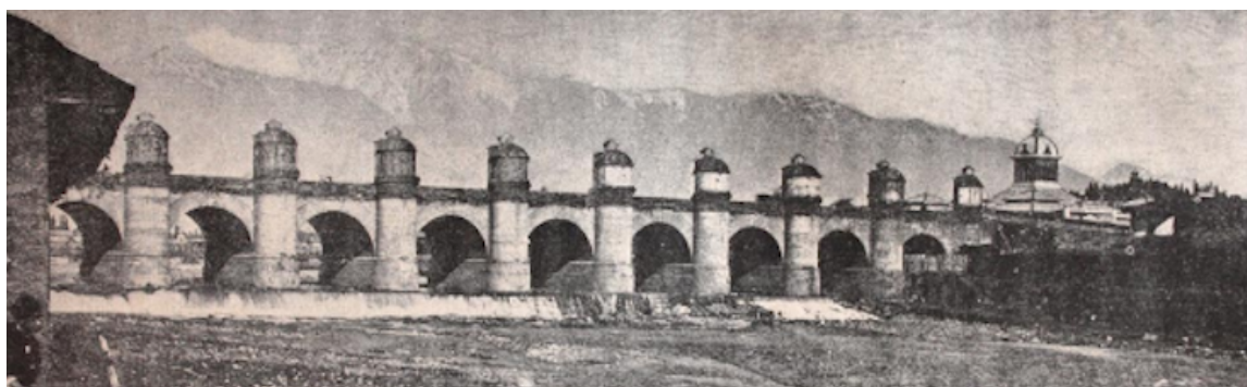
Figure 33. Le pont Cal y Canto en 1888.
