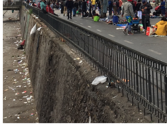
Mardi 19.10.19 – 12h00. Vue vers l'est Déchets accumulés sur la rive inférieure sud du Mapocho, le long de la piste cyclable 42k et du marché aux puces
