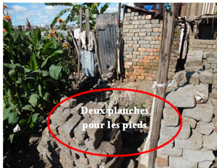
Photo 6 : Un kaboné à fosse sans toit et équipé de deux planches pour les pieds
