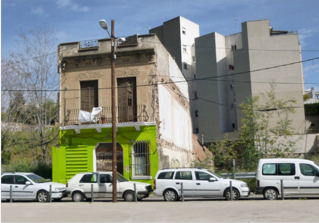
Photographie 36 : La Fusteria 1 peinte, signifiant sa démolition prochaine
