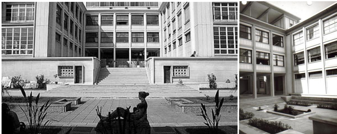
Figure 12 : Façade principale et cours d'honneur de l'école nationale des beaux-arts d'Alger (alger-roi.fr)
