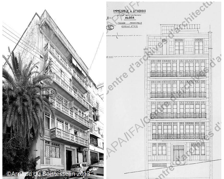
Figure 123 : Façade de l'immeuble à studios avant modifications, Alger (Cité de l'architecture et du patrimoine)
