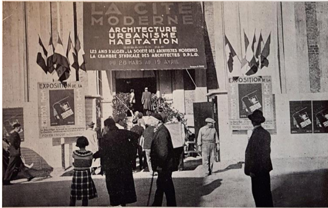
Figure 112 : L'entrée de l'exposition, foyer civique, Alger, mai 1936 (Algeria, 1936, p. 31)
