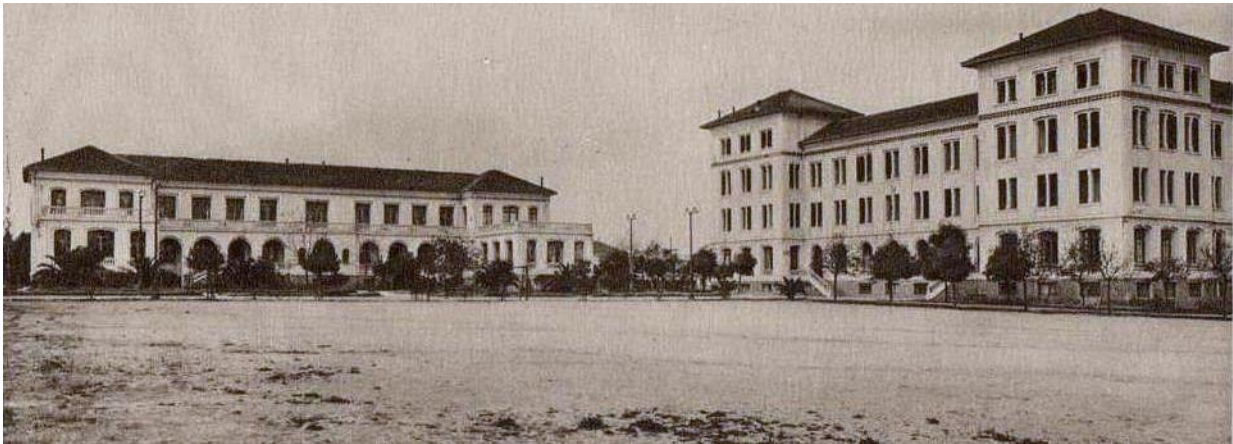
Figure 14 : Vue d'ensemble sur l'institut industriel d'Algérien, salle de cours et direction, Maison-Carrée (Alger-rois.fr)
