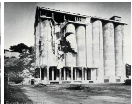
Figure 51 : Les docks silos détruits en 1942 (Seybous.info) consulté en novembre 2019
