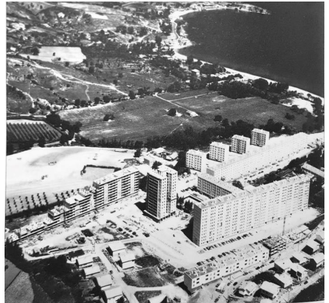
Figure 58 : Vue d'ensemble sur le chantier de la cité du Oued Kouba, CIA, 1960 (Paul Piro, op.cit., p. 86)
