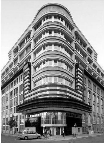
Figure 84 : L'immeuble « Mossehaus », Berlin, 1923 (Pinterest)
