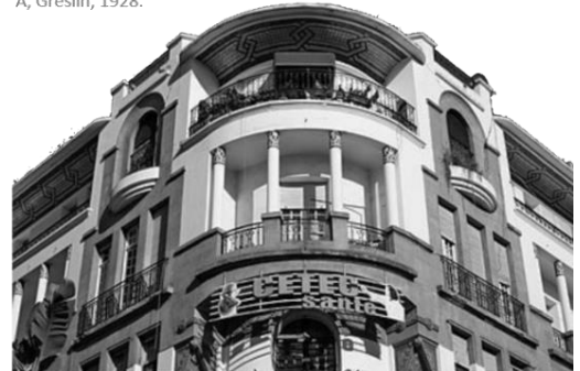
Immeuble rue Prince Moulay Abdalah, Casablanca.
