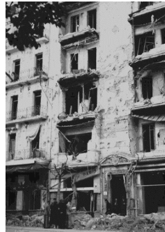
Figure 8 : Immeuble à Alger, rue Michelet affecté par les bombardements, 1943 (chezpeps.free.fr)
