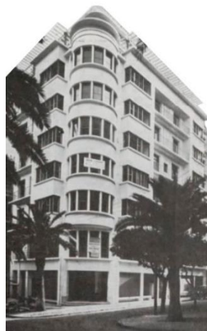
Figure 82 : Immeuble à Alger, Bd Victor Hugo, Arch: R. Lugan, 1932 (CNA)
