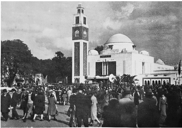
Figure 4 : Le pavillon de l'Algérie, exposition coloniale ,1931, Vincennes (Algeria, 1937)
