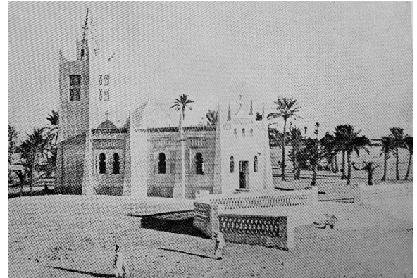
Figure 60 : L'église de Ouargla de style néo-soudanais (Algeria, 1933, p. 30)
