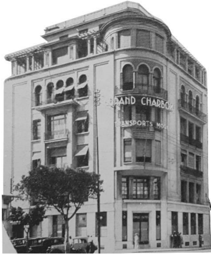
Figure 78 : Immeuble des années 1930 à caractère oriental, au 2 boulevard Baudin, Alger (Algeria)
