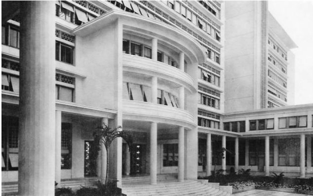
Figure 121 : Porche d'entrée du palais du Gouvernement général (Wikipédia)
