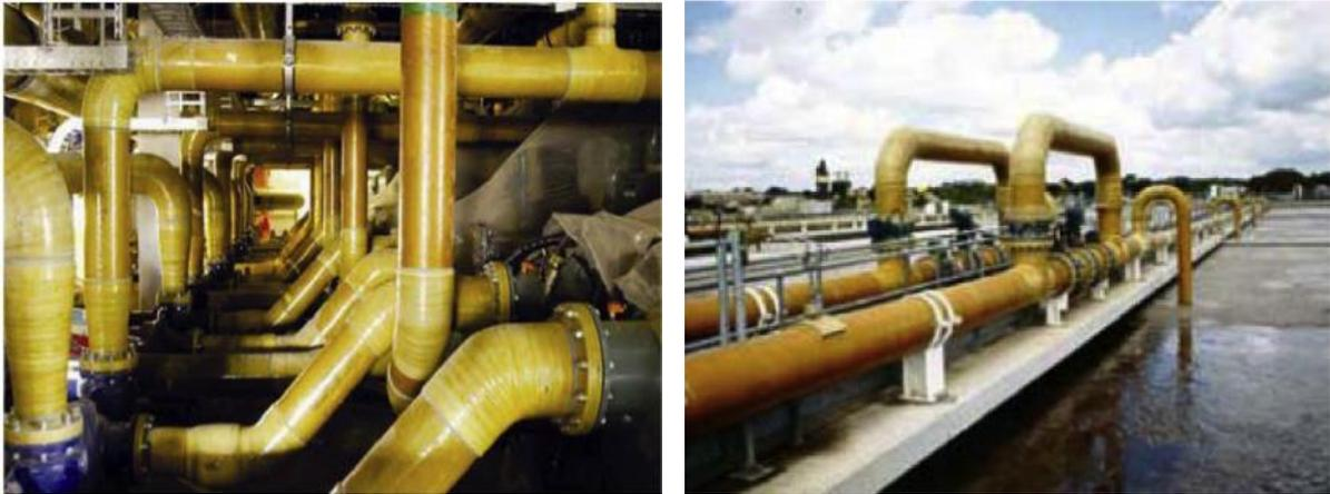
Figure 1-2: Pipes en époxy renforcé de fibres de verre (PRV) pour l'eau de refroidissement - Images de Future Pipe Industries (FPI).
