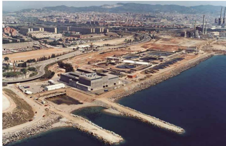
Figure 71: Construction du Forum, Années 2000 ©Revista de Obres Públiques
