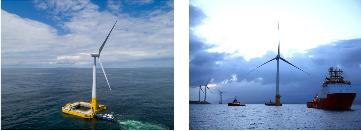
(a) FLOATGEN - Barge Type FOWT
