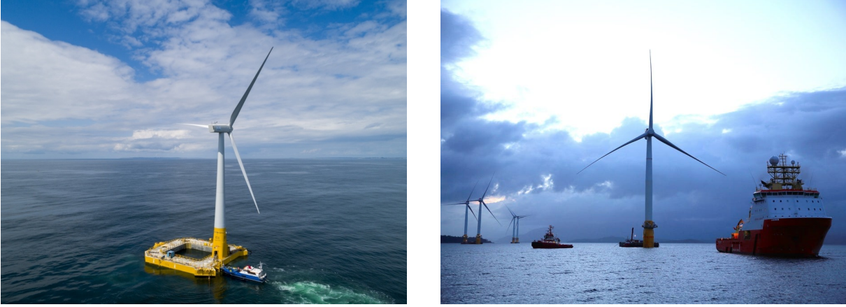
(a) FLOATGEN - Barge Type FOWT
