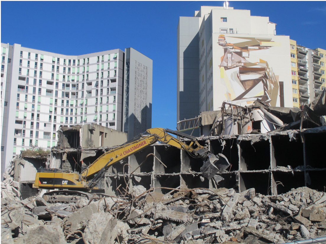
Figure 27 : Démolition du parking silo n°4 au pied des 40 et 50 Arlequin. Photographie Maïlys Toussaint, 17 octobre 2017.
