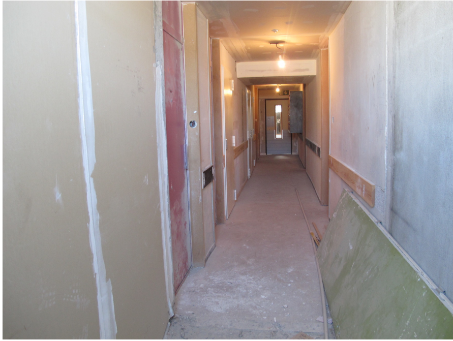
Figure 42 : Coursive au 40 Arlequin. Photographie Maïlys Toussaint, 22 octobre 2016.
