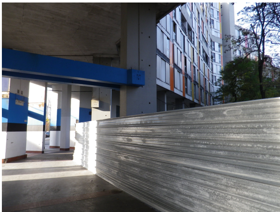
Figure 37 : L'enclos du chantier et ses barrières de taule empêchent la traversée de la galerie en dessous du 40 Arlequin. Photographie Mailys Toussaint, 11 novembre 2015.
