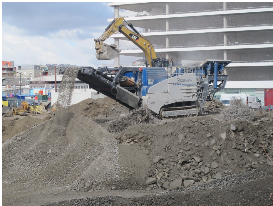
Figure 28 : Gestion des gravats de la démolition des parkings silos, Photographie Maillys Toussaint, 12 février 2018.
