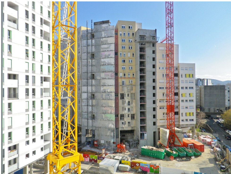
Figure 2 : Vue sur le 50 Arlequin depuis les appartements du 40 Arlequin. Photographie Mailys Toussaint, 19 mars 2016.
