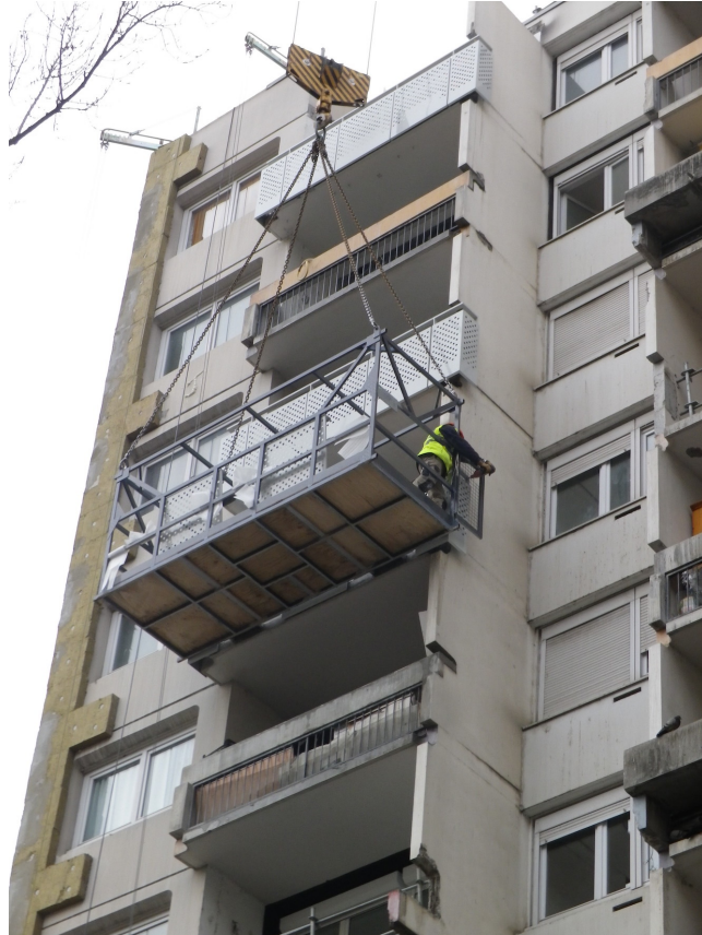
Figure 40 : Remplacement des garde corps en cours sur les balcons du 50 Arlequin. Photographie Maïlys Toussaint, 28 janvier 2016.
