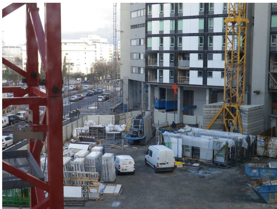
Figure 36 : Vue sur l'intérieur de l'enclos de chantier et sur le 40 Arlequin, depuis la fenêtre d'un appartement du 50 Arlequin. Photographie Mailys Toussaint, 5 février 2016.
