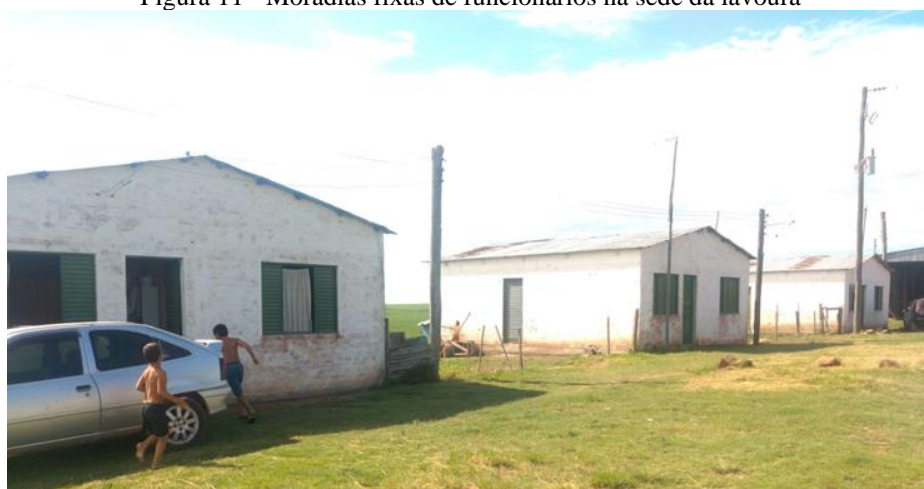
Figura 11 - Moradias fixas de funcionários na sede da lavoura
