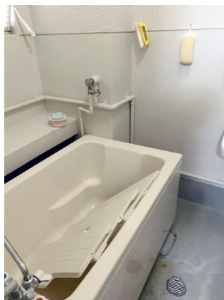
Figure 2 : salle de bains d'un appartement public rénové pour accueillir un ménage âgé. Modernisation des équipements et installation de main-courante.
