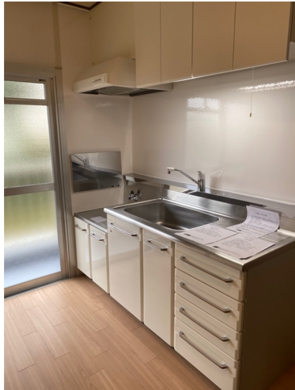
Photo 8 : Cuisine d'un logement public refait à neuf avant son occupation
