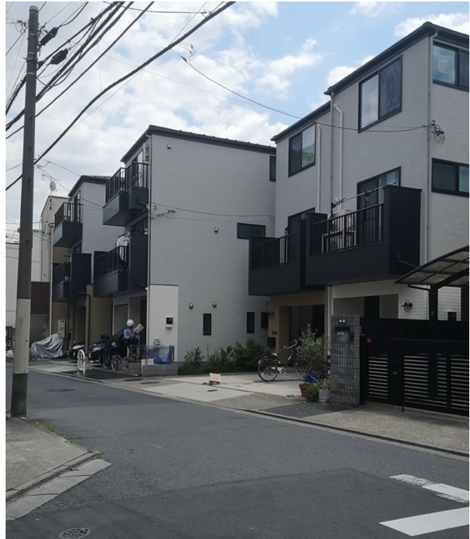
Photo 36 : Lot de maisons individuelles construites récemment à Adachi. Elles témoignent d'une forte standardisation.
