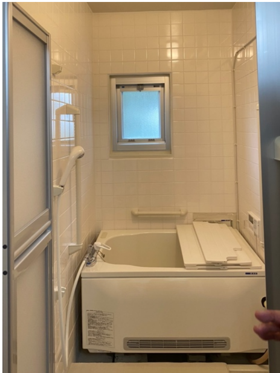
Photo 10 : Salle de bains dans un logement public japonais refait à neuf avant son occupation
