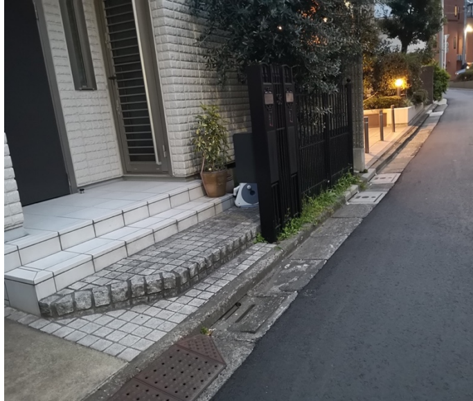
Photo 24 : Entrée depuis la rue dans une habitation. De nombreux obstacles sont visibles (marches, chaussée). L'entrée est isolée du reste de la rue de cette façon, mais difficilement accessible pour une personne à mobilité réduite.
