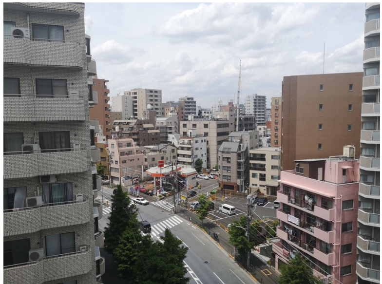
Photo 33 : Vue depuis un immeuble d'habitations de grande hauteur (manshon) à Bunkyo. L'immeuble est localisé sur un axe important de circulation. On y voit les immeubles d'en face, leur opacité et la non-appropriation des balcons.
