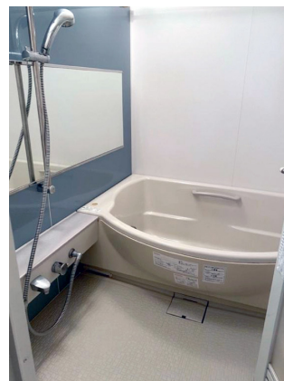
Figure 3 : salle de bains d'un appartement d'une construction datant des années 2000. L'entrée dans l'espace est sans obstacle, la baignoire est basse et une main-courante est installée.
