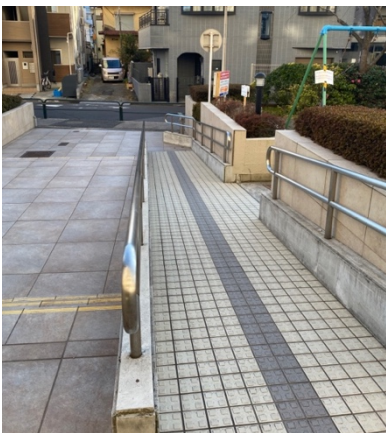
Photo 38 : Large et longue rampe devant un immeuble d'habitations collectives à Adachi. L'espace devant l'immeuble étant important, la rampe est en ligne droite.
