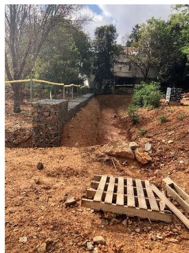
Photographie 2 : Limite physique en bordure d'une zone résidentielle. Le fossé complique la sortie du parc par les animaux (côté droit), la faible hauteur du mur facilité leur retour. Barcelona, 7 septembre 2022, Carole Marin
