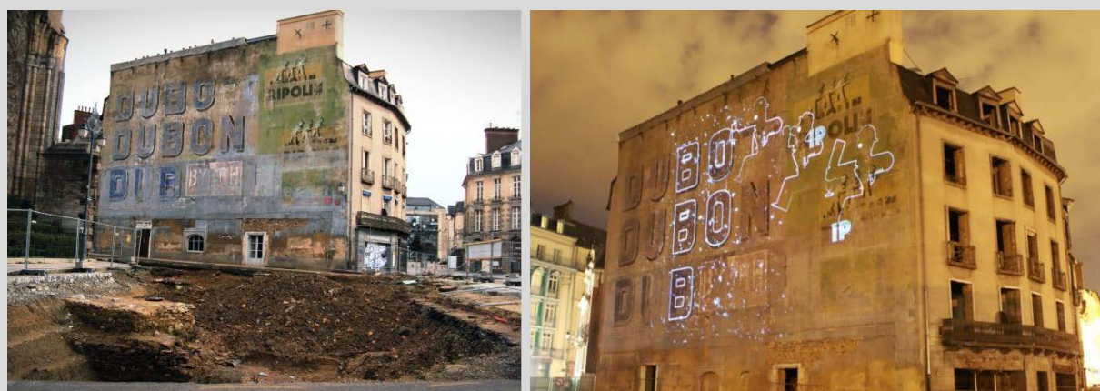
Fig. 21 : Photographie du concert/mapping hommage au mur publicitaire de l'îlot 20-21 de la place Sainte-Anne, le 1 er juin 2014. Les publicités peintes visibles sur la façade Ouest du bâtiment construit en 1908 pour les marques Dubonnet, Byrrh et Ripolin d'après l'affichiste Vavasseur datent des années 1950. (Photos : La Sophiste, 2014)
