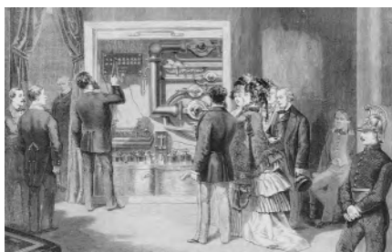
Fig. 7 : L'appareil électrique servant à l'allumage des becs de gaz de la salle des séances de l'Assemblée
