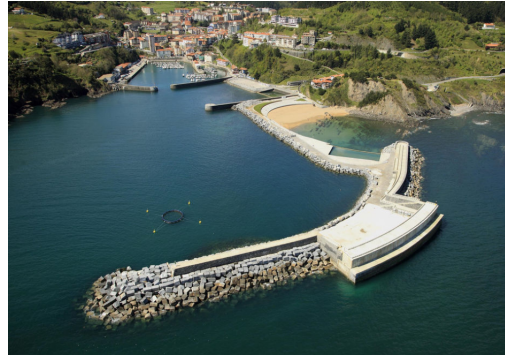
(b) Photo de la centrale de Mutriku (Espagne).
