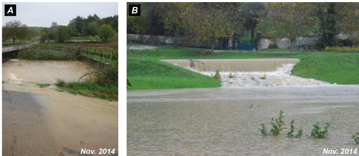
Figure 6.22 : Occurrence d'un événement basse fréquence / haute magnitude en novembre 2014 dépassant la capacité de charge des pièges à sédiments du bassin versant du Giroux (source : Grand Chalon, 2018). (A) Bassin décanteur de type A (525 m 3 ) saturé à l'exutoire du sous-bassin versant des Vaux ; (B) Remplissage de l'étang du Pont Latin par surverse d'un bassin d'orage adjacent de 6 130 m 3
