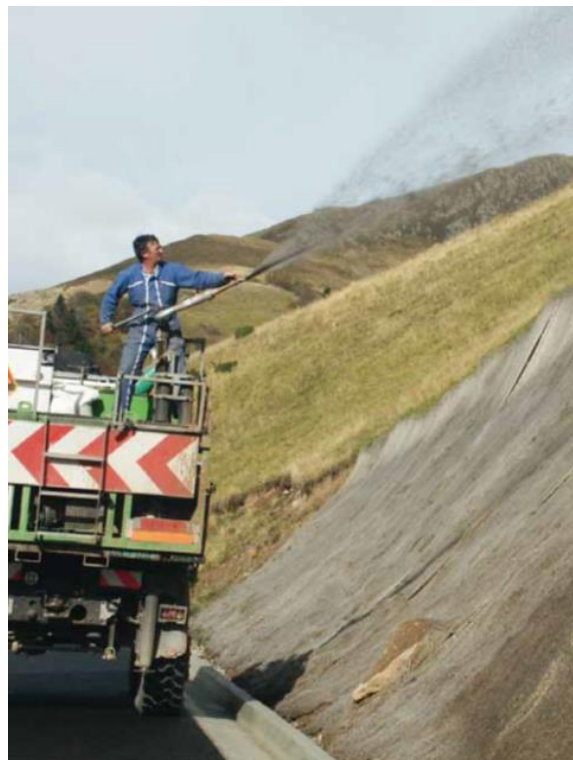
Figure 9 : Ensemencement d'un talus par hydroseeding (Photographie tirée de Dupin B., Malaval S. et al., 2014. Comment reconstituer la flore en montagne pyrénéenne ?)
