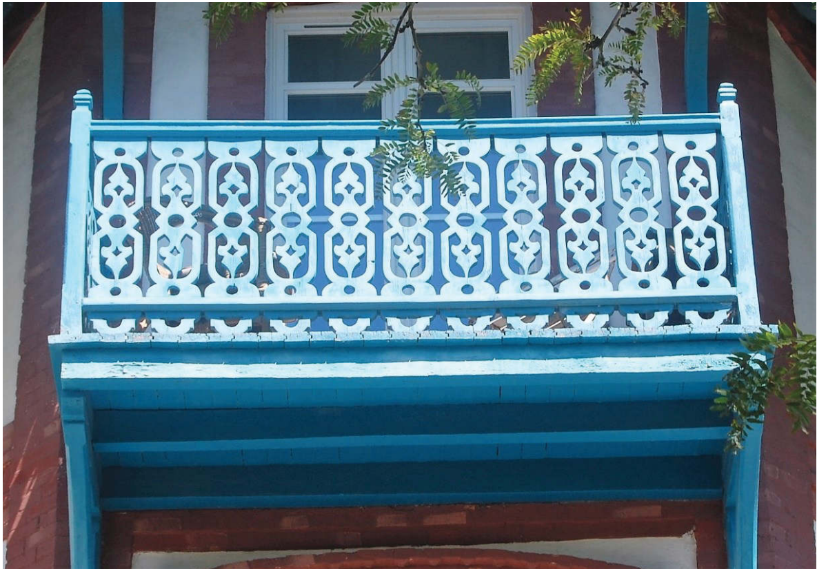
Figure 195 A-B. Les bois découpés, exemples de balustres. A. Villa Toledo B. Villa L'Ensoleillée
