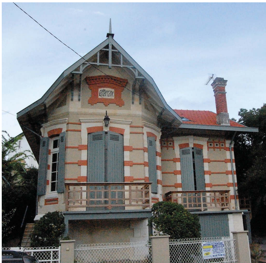
Figure 203. I. Dotte. La villa Cantarane , de Marcel Ormières, photographie, 2017
