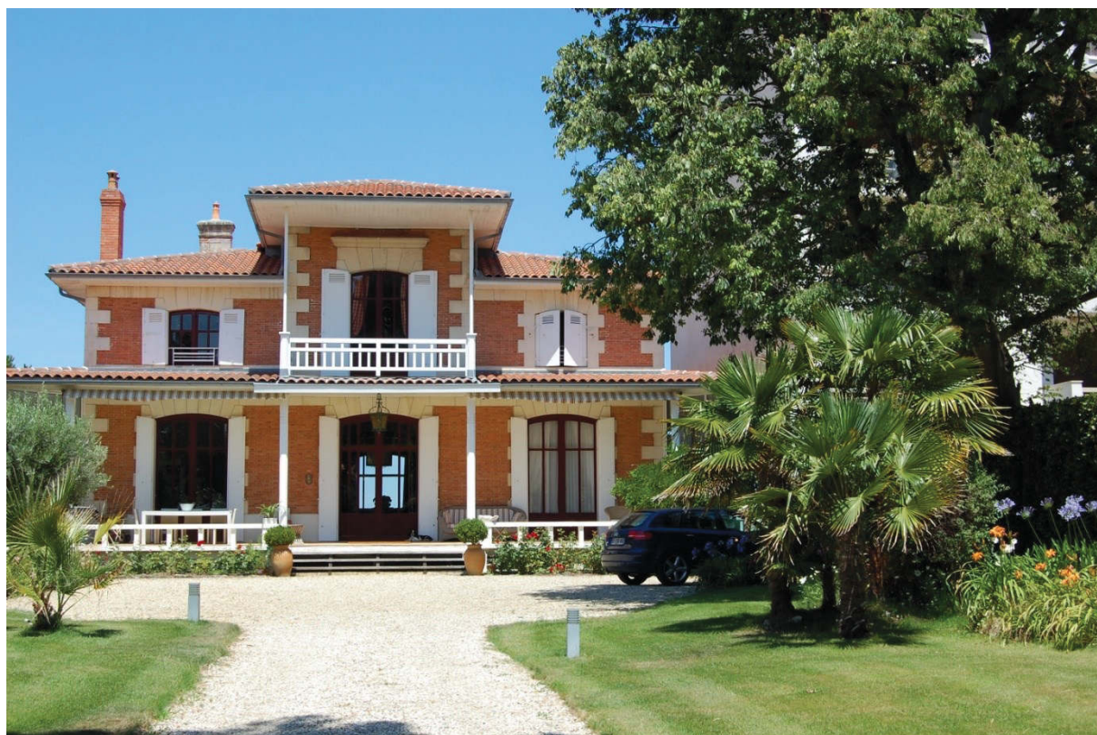
Figure 83 A-B. A. Alphonse Terpereau. Villa Grangeneuve , s. d., in « Vues d'Arcachon », album de photographies, AMA B. I. Dotte. Villa Grangeneuve , la même façade, côté boulevard de la Plage, photographie, 2015
