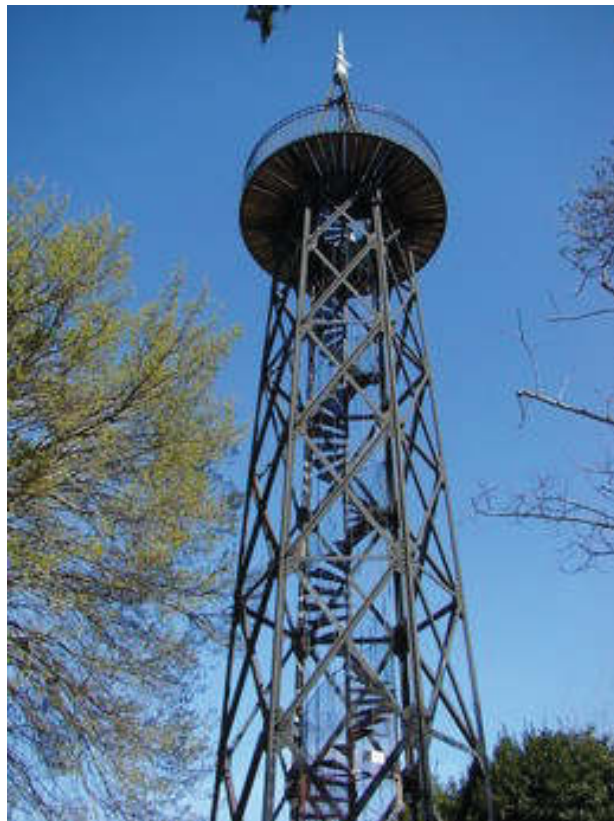
Figure 111 A-B. A. Arcachon- Le belvédère , carte postale, photographie antérieure à 1906, site leonc.free.fr B. L'observatoire de nos jours, site bassinarcachon.org
