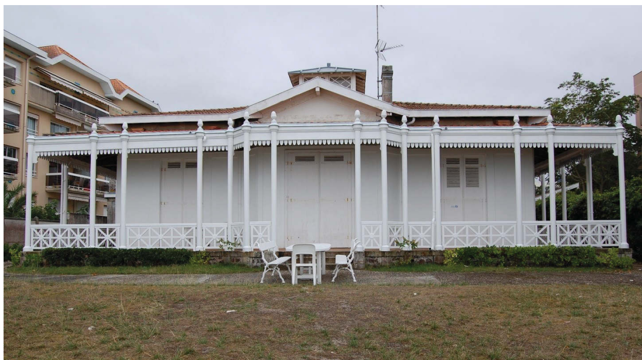
Figure 82 A-B. I. Dotte. Villa Salessè , l'angle nord-est et la façade sur le bassin, photographies, 2015
