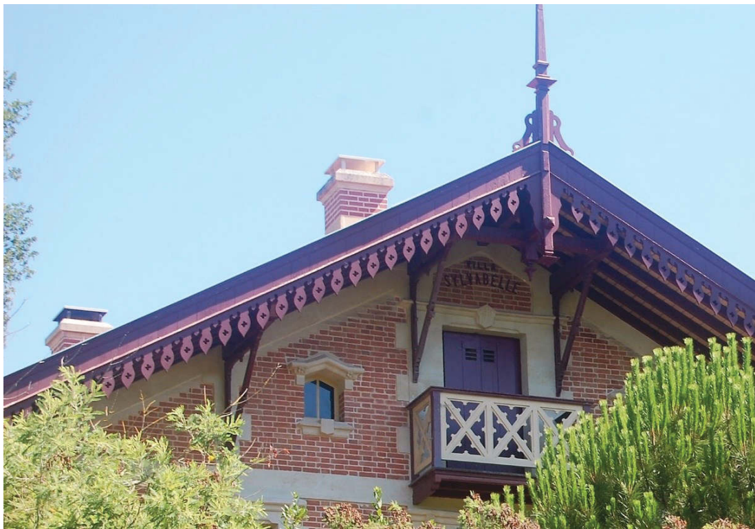
Figure 197. I. Dotte. Villa Sylvabelle , les lambrequins de la toiture
