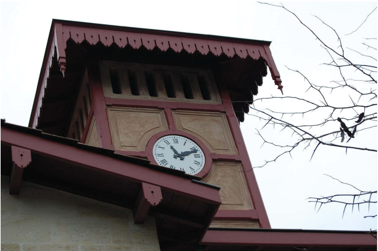
Figure 200. I. Dotte. Le lanterneau des écuries du parc Pereire, photographie, 2015
