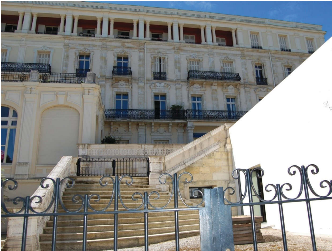
Figure 191 A-B-C-D. A. I. Dotte. Le Grand Hôtel , angle nord-ouest, photographie, 2017 B. I. Dotte. Une partie de l'escalier monumental, au nord
