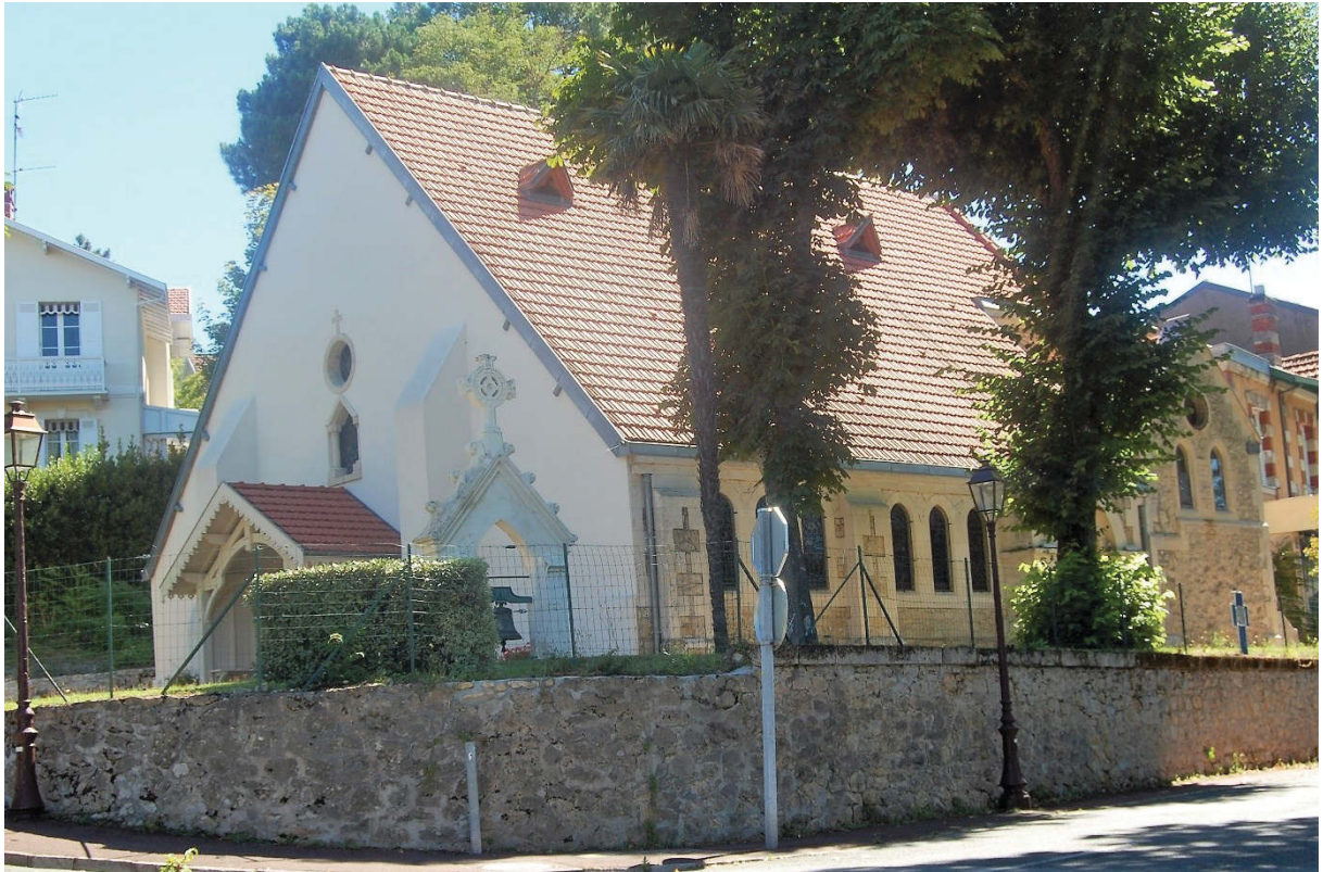
Figure 178. I. Dotte. Temple évangélique , place des Palmiers, photographie, 2017
