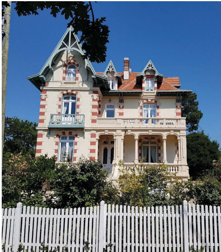
Figure 193 A-B. A. Marcel Ormières. Villa Burgundia , planche in Villas et Cottages des bords de l'océan , 1910 B. I. Dotte. La villa aujourd'hui, photographie
