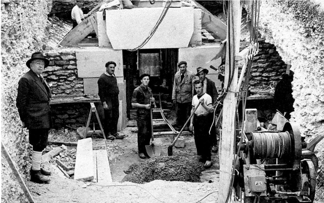
FIGURE 1.4 – Travaux d'aménagement des années 1947-1948 (Fernand Windels) - construction d'un Sas à l'entrée de la grotte.
