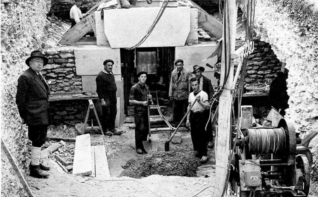
FIGURE 1.4 – Travaux d'aménagement des années 1947-1948 (Fernand Windels) - construction d'un Sas à l'entrée de la grotte.
