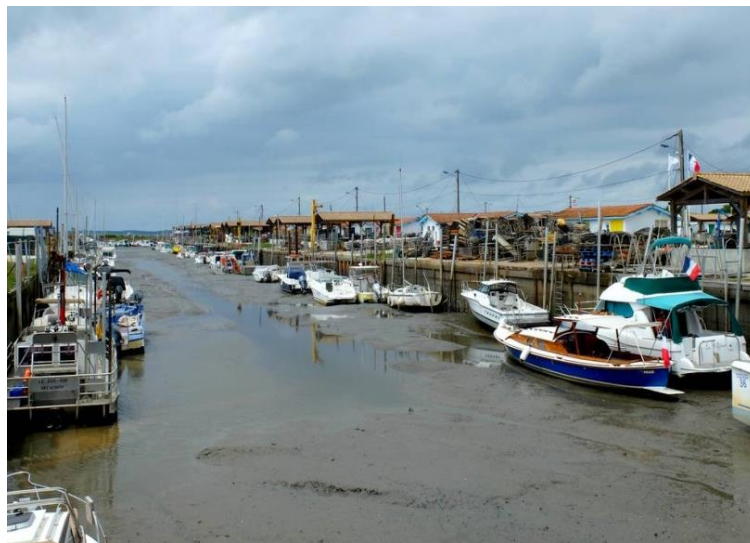
Figure 1-1 : Exemple d'envasement de port à marée basse – Photo du Port de Gujan-Mestras
