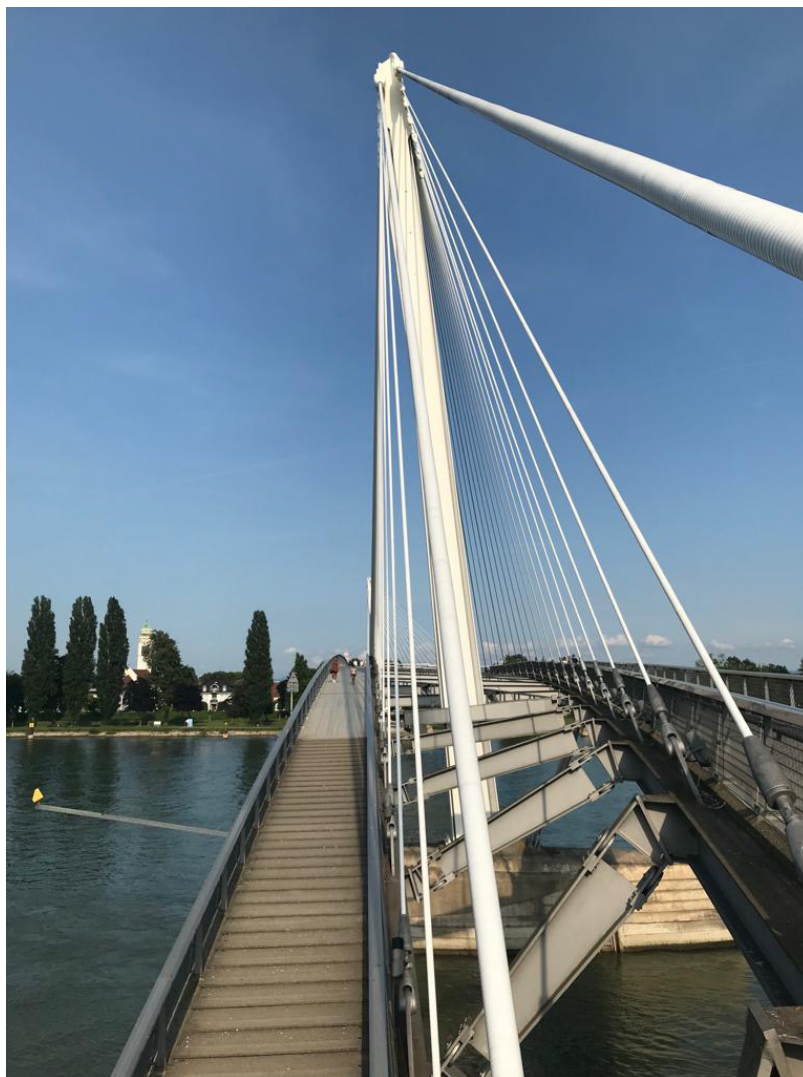
Figure 16. La passerelle Mimram, qui traverse le Rhin entre Strasbourg et Kehl. 2021. Photo prise par l'auteur.
