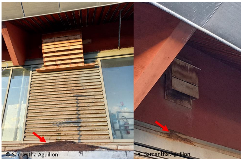
Figure 16. Exemple de gîtes artificiels de différentes tailles mis en place sur le toit de l'aéroport à La Réunion. Ces gîtes sont occupés comme on peut le voir avec le guano en-dessous (flèche rouge).
