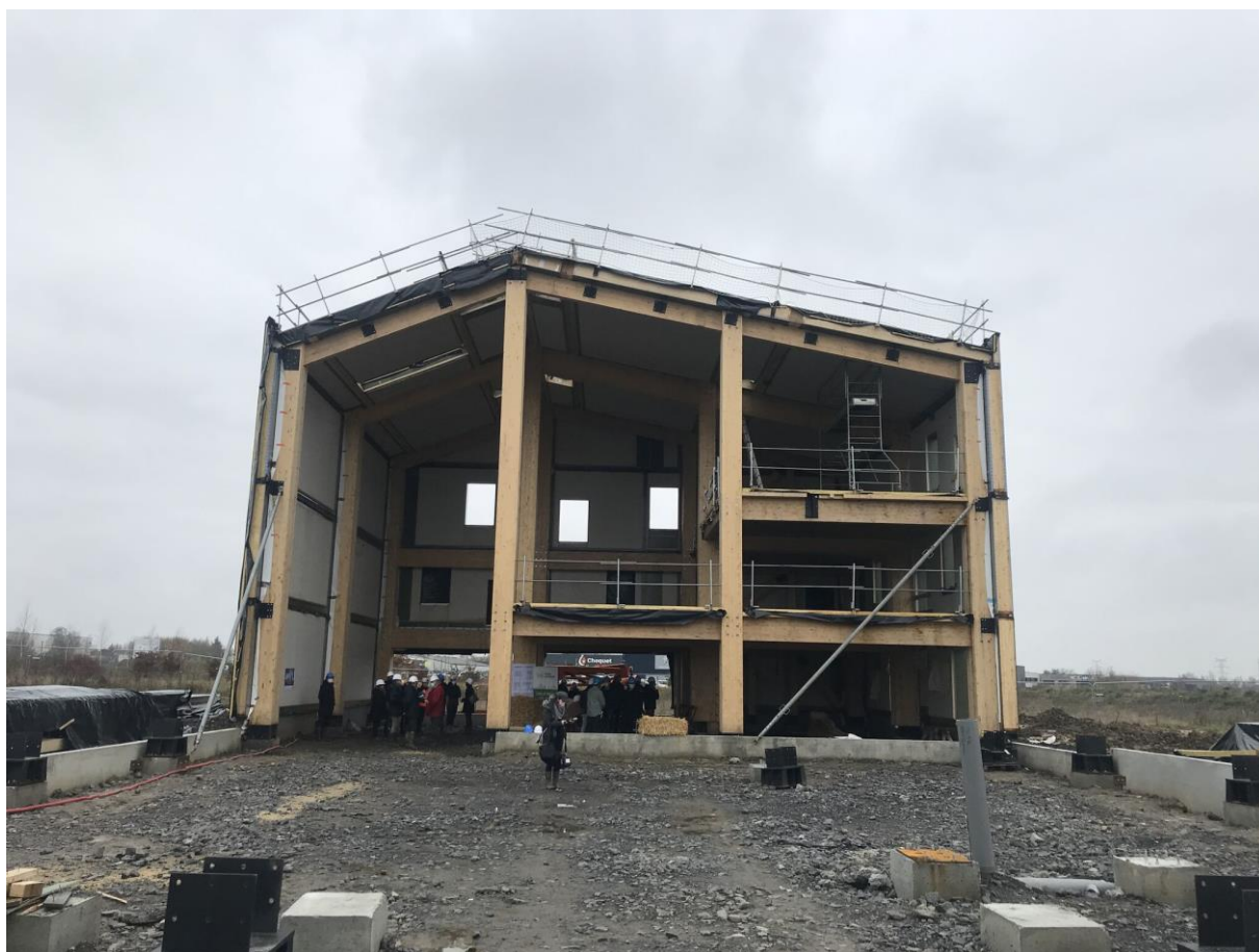
Figure 41 : Chantier de la Passerelle. Source : Pévèle-Carembault, 2021.
