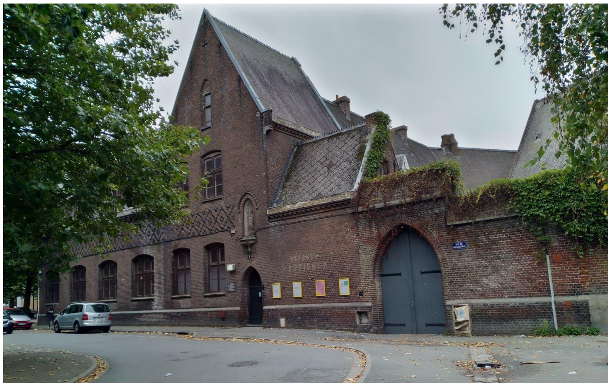
Figure 42 : Couvent des Clarisses à Roubaix. Source : auteure, 2021.
