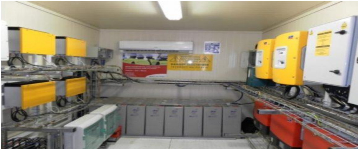
Figure 110. Système de monitoring pour l'implantation de la station de traitement de l'eau au Lycée de Sidi Taibi
