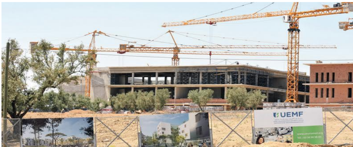
Figure 107. Chantier de construction de l'éco-campus de l'UEMF
