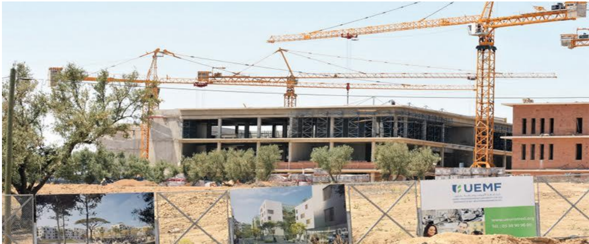
Figure 107. Chantier de construction de l'éco-campus de l'UEMF
