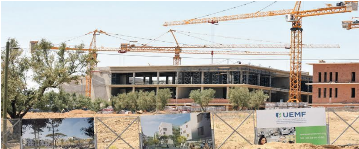
Figure 107. Chantier de construction de l'éco-campus de l'UEMF
