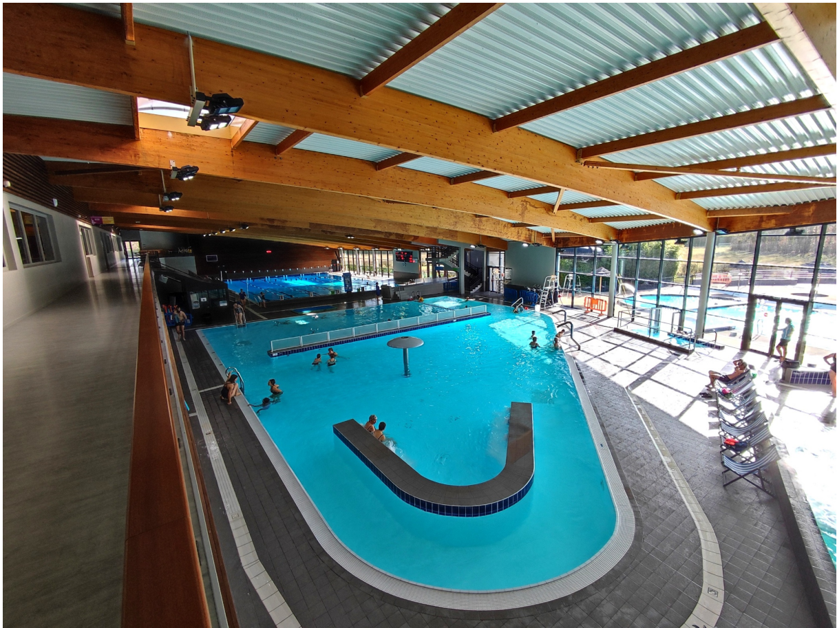
Image 7. Halle bassins intérieurs – Agl'eau (photo prise par l'auteur, le 07/02/2022)
