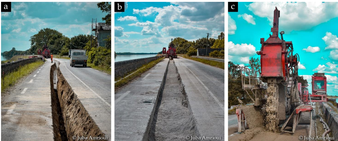
Fig. 8. (a) Réalisation de la prétranchée ; (b) Epandage du ciment ; (c) Malaxage et injection d'eau (© J. Amrioui – site LA)
