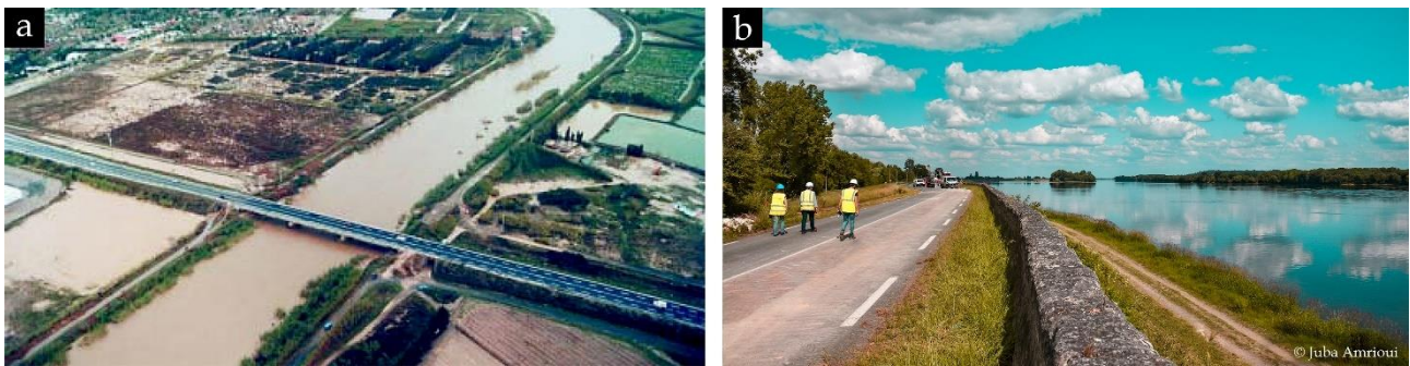
Fig. 2. (a) Vue aérienne du cours aval endigué du fleuve côtier Agly, juste après la crue des 12-13/11/1999 (© F. Hédelin – Pyrénées Orientales) ; (b) Une levée de la Loire Moyenne : digue en remblai avec une voie de circulation en crête (© J. Amrioui – site LA).
