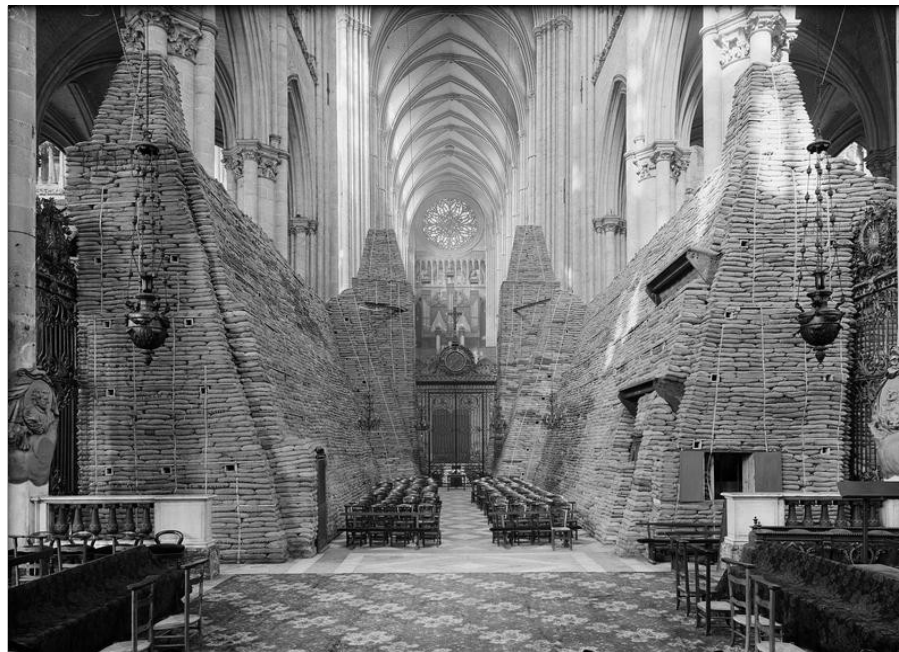
Figure 50 : Emmanuel Mas, Protection des stalles, vue vers le chœur durant la Seconde Guerre mondiale, cathédrale d'Amiens , date inconnue, négatif, 13 x 18 cm, Montigny-le-Bretonneux, Médiathèque du patrimoine et de la photographie (MH00120739) ©Mas/Ministère de la Culture (France)/MPP/diffusion RMN-GP.
