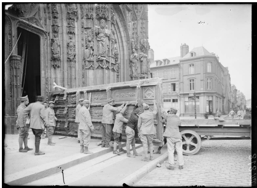
Figure 28 : Opérateur DU [Henri Dufour], Enlèvement des Grandes Portes par le Service du Front Nord, chargement des portes sur le camion, négatif, plaque de verre, 13 x 18 cm, Ivry-sur-Seine, ECPAD (DU000818).
