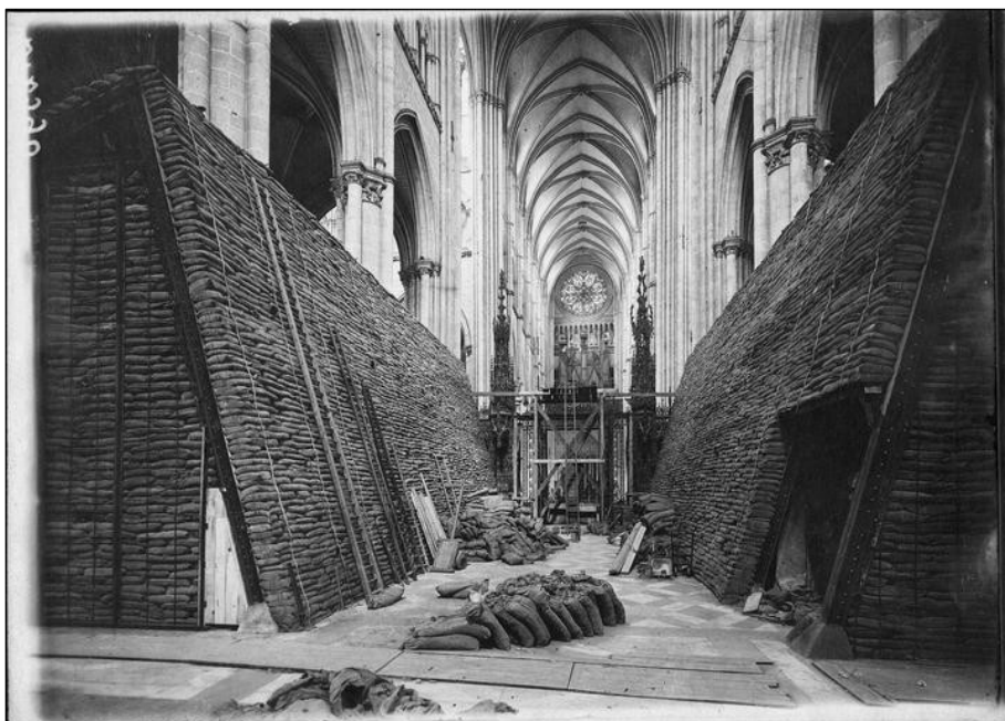
Figure 51 : Opérateur Z [Isidore Aubert], Le chœur protégé par des sacs de terre, Cathédrale d'Amiens , 1916, négatif, plaque de verre, 13 x 18 cm, Ivry-sur-Seine, ECPAD (Z002390). ©Aubert/SPCA/ECPAD/Défense/SPA 50 Z 2390
