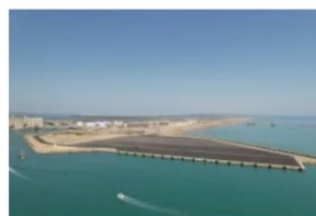
Le port de Port-La-Nouvelle est étendu afin de permettre la construction et la maintenance des éoliennes flottantes.
