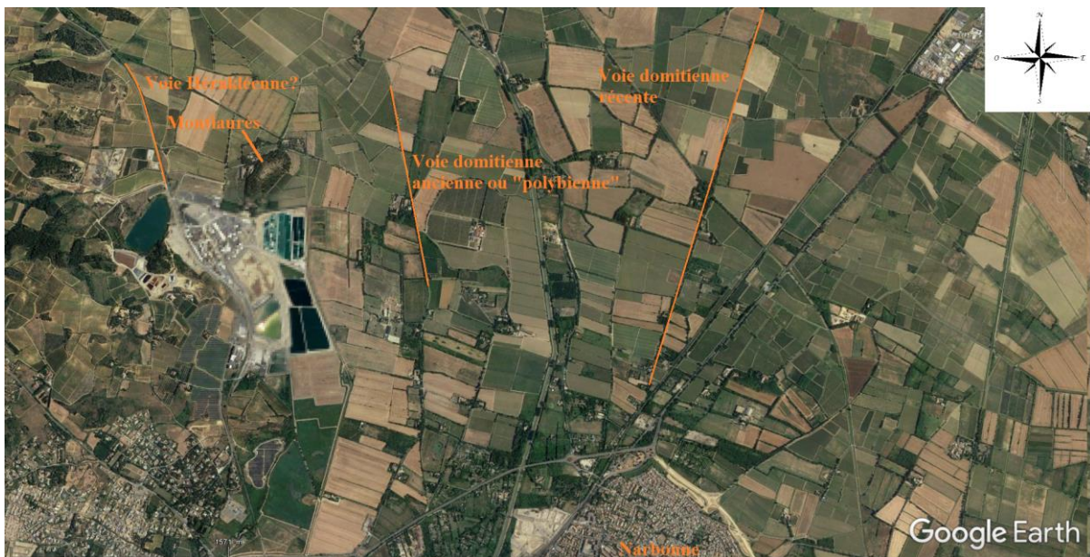
Figure 41. Réseau routier ancien dans le secteur de Narbonne-Montlaurès.
