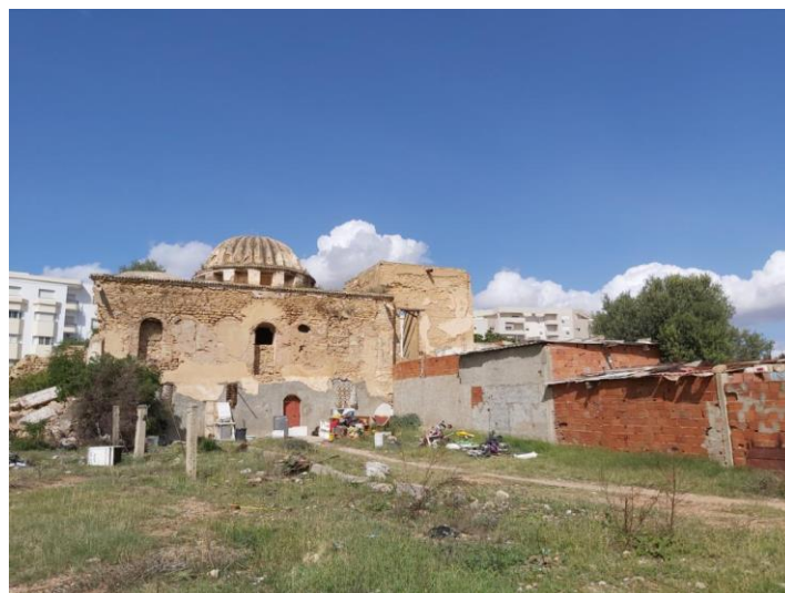
Figure 80. La partie basse du Bùrj occupée. (Source: Hamrouni, 2020)
