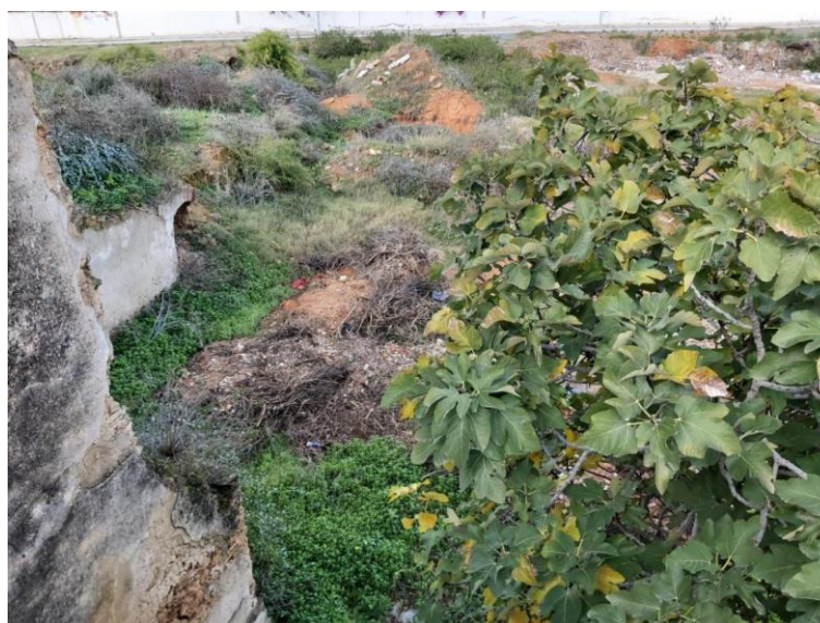
Figure 74. La végétation envahissant le patio central. (Source : Hamrouni, 2020)
