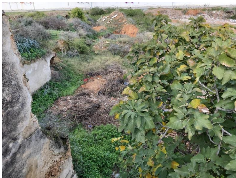
Figure 74. La végétation envahissant le patio central. (Source : Hamrouni, 2020)
