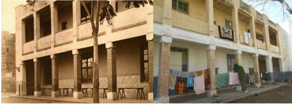
Figure 41. L'école de la rue du tribunal entre hier et aujourd'hui. (Source : Montage Hamrouni, 2022)
