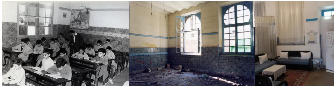
Figure 43. Une salle de classe entre l'abandon et l'oukalisation. (Source : Montage Hamrouni, 2022)
