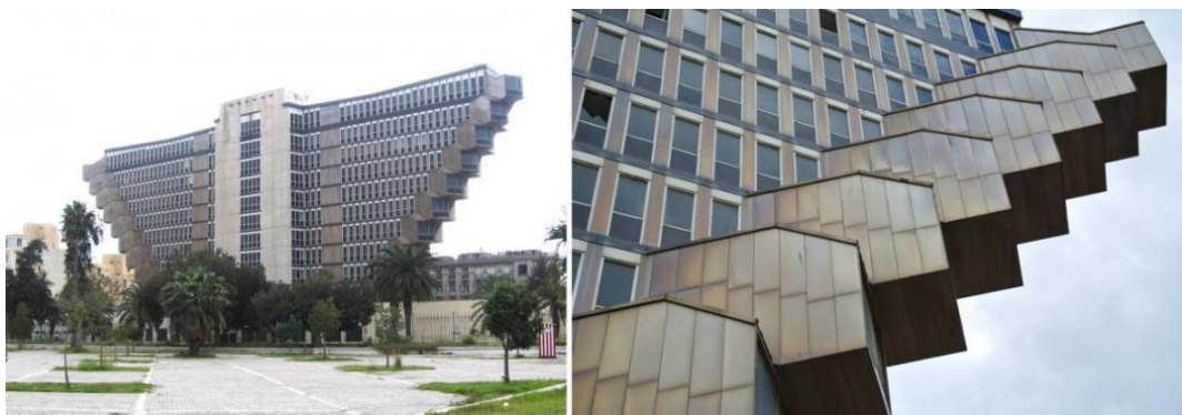
Figure 20. L'hôtel du Lac, une icône du brutalisme à l'échelle internationale en risque de démolition. (Source: Kapitalis, 2020)
