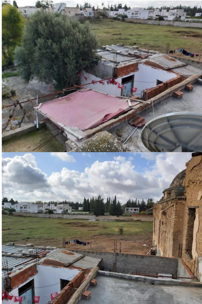
Figure 81. Les extensions perceptibles à l'œil nu par le changement de matériaux et de couleurs. (Source : Hamrouni, 2020).
