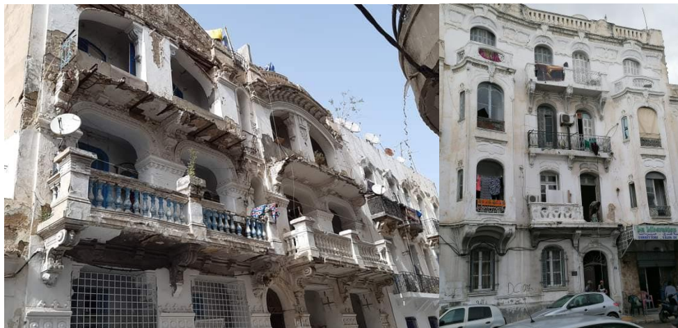
Figure 21. L'état actuel déplorable d'un nombre de bâtiment du patrimoine moderne en Tunisie. (Source: Hamrouni, 2020)
