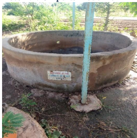
Photo 15 : Un puits moderne
