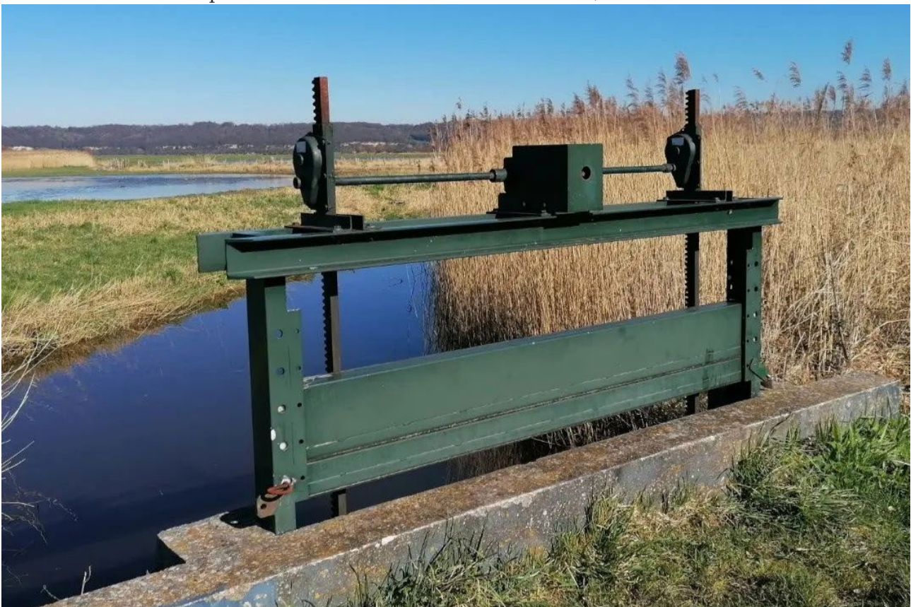
FIGURE IV.1 : Vanne d'eau dans la RNN de l'estuaire de la Seine, servant à gérer les mouvements d'eau au cours de l'année (Photo : Maison de l'Estuaire).
