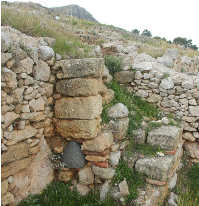
Figure 353. Meta de moulin biconique So-015, employée comme matériau de construction pour un escalier (insula 8) (photographie : J. Lang).
