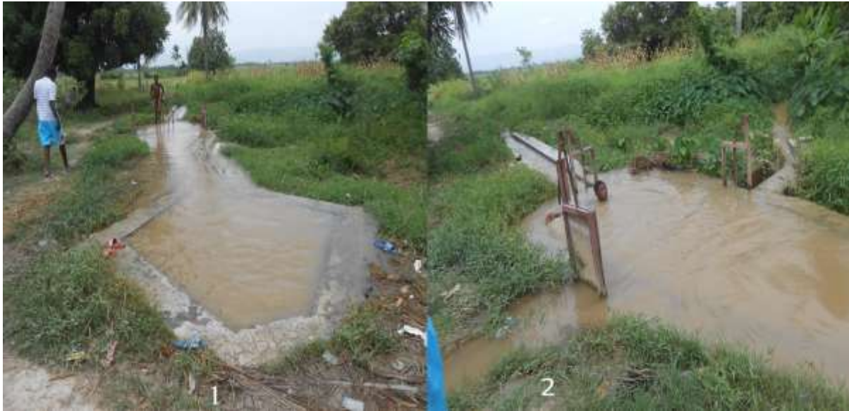
Figure 24 : Bassin de distribution financé par CECI à Liancourt
