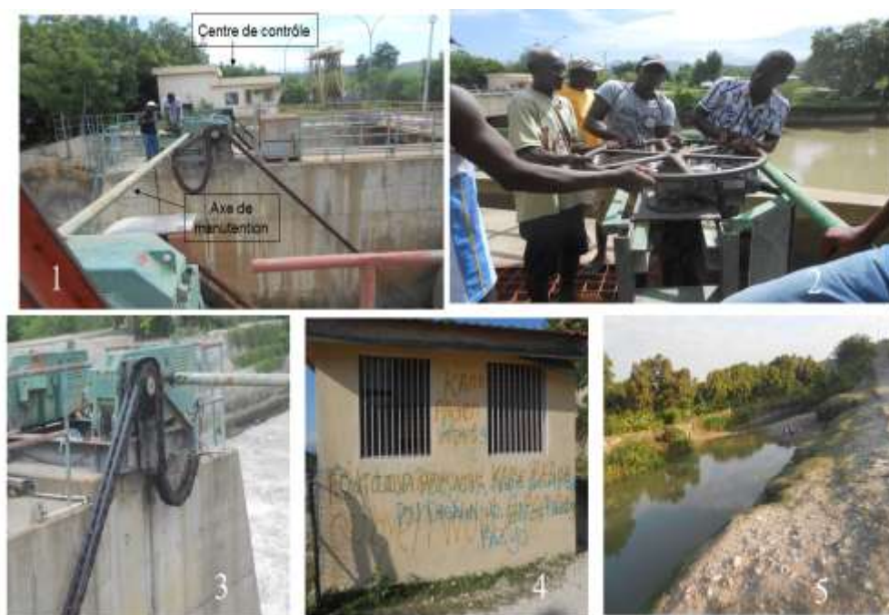
Figure 21 : Centre de contrôle automatique, la manutention manuelle à l'alimentation des canaux primaires.
