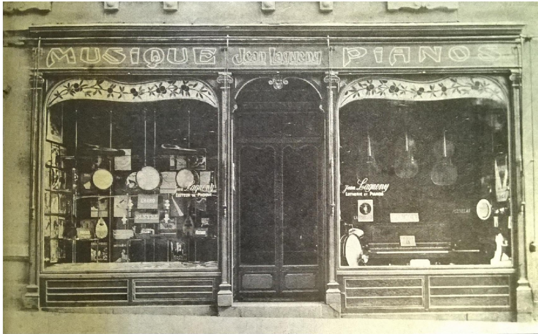
Figure 23. Vitrine de la boutique Laguenny, boulevard Carnot, en 1927 260 .
