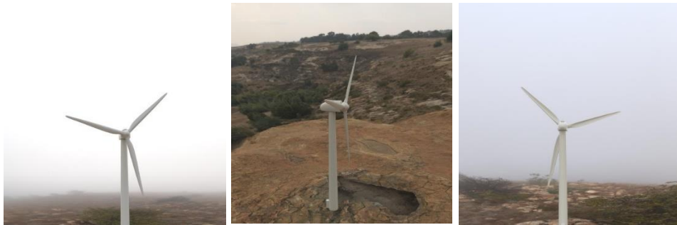
Figure 24. Modélisations d'une éolienne dans différents environnements et selon différents points de vue. Sur ces images, l'éolienne possède les mêmes caractéristiques de réflectance que l'un des échantillons de pale. Chaque pixel est codé selon un triplet RGB.
