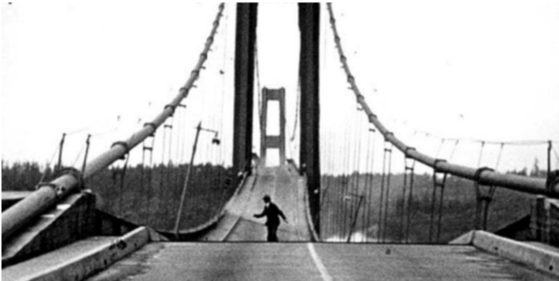
Figure 2.6 - Pont du détroit de Tacoma (E.U.) subissant un phénomène de vibrations auto-excitées
