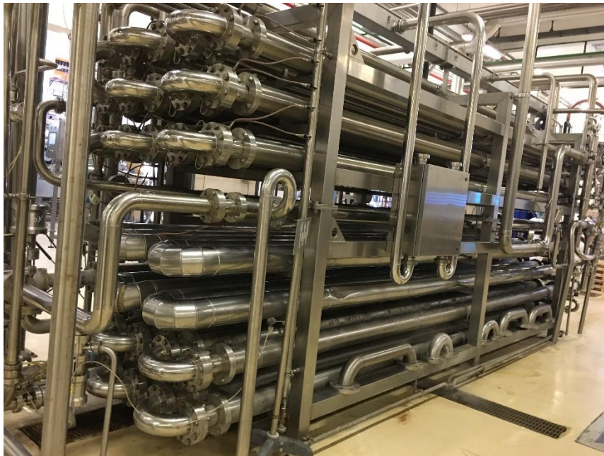
Figure 16 : Stérilisateur aseptique « tube in tube » (Photo C.P.C.C. Martins)
