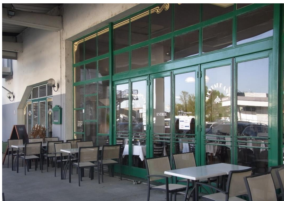
Image 5 : Façade du restaurant
